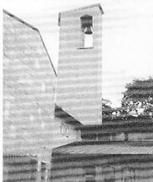
Komin krematorium pomysłowo umieszczono w obrębie dzwonnicy.
